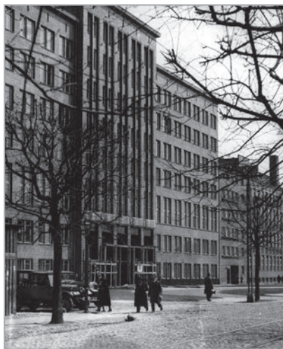
Siedziba Ministerstwa Robót Publicznych przy ulicy Chałubińskiego w Warszawie. NAC
